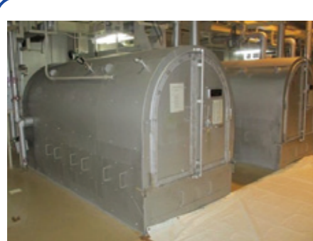
ウラン供給設備解体前
